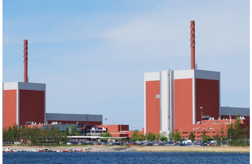
rawpixel/Wikimedia Commons Finland's Olkiluoto 3 nuclear power plant
